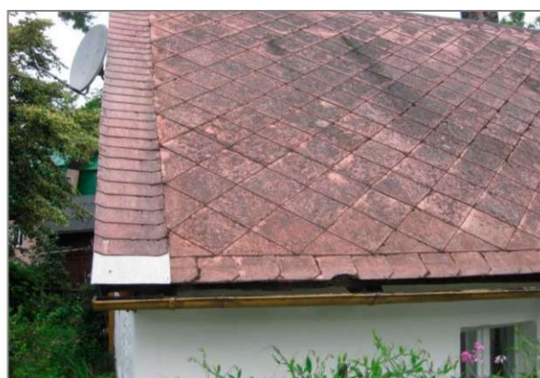
Fot. 2 Płyty azbestowo-cementowe płaskie
